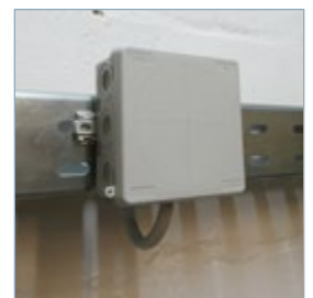
Die EDV sind für die Installation in den Langlöchern der Kabelbahn geeignet. Siehe S. 116.
