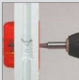
Etriers métalliques pour fixation dans carreau de plâtre
