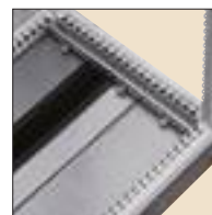
Exemple de plaque passe-câbles à balai installée dans une armoire Altis
