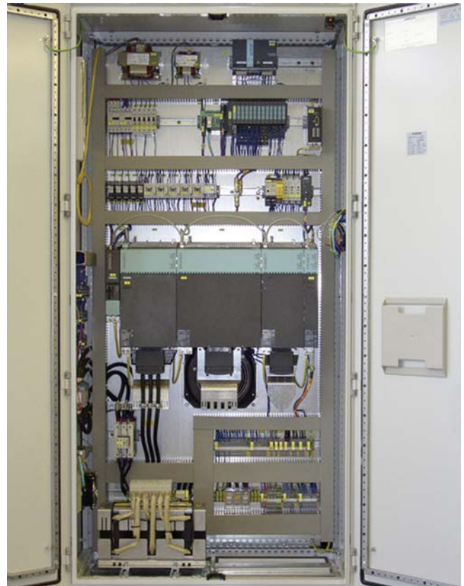
Armoire électrique avec SINAMICS S120 de forme Booksize
