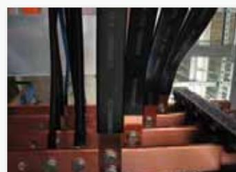
Las barras **Ω FLEX** están realizadas con láminas de cobre rojo (Cu ETP) revestidas con un aislamiento de PVC extruido, que ofrece un óptimo aislamiento eléctrico incluso en presencia de humedad, altas temperaturas y ambientes agresivos.
