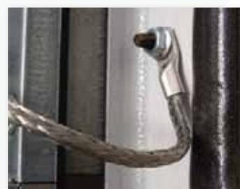
La trenza de cobre se utiliza como conductor extra flexible para todas las necesidades de conexiones eléctricas comprendidas las conexiones de potencia, de tierra y equipotenciales.
