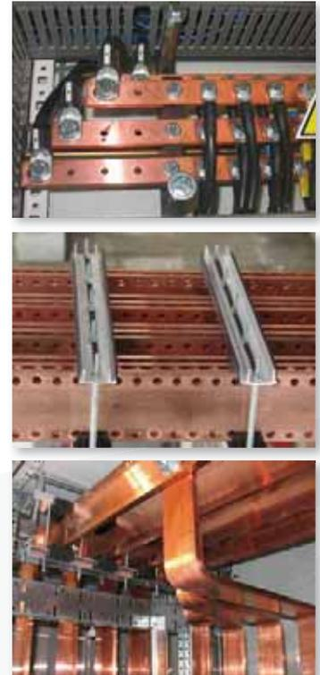
En los cuadros eléctricos actualmente se emplean dos metales como conductores: el cobre y el aluminio. En especial, si se debe definir una distribución de potencia en el interior de un cuadro eléctrico, se recurre principalmente al empleo de barras trefiladas, utilizando los dos metales arriba indicados.
