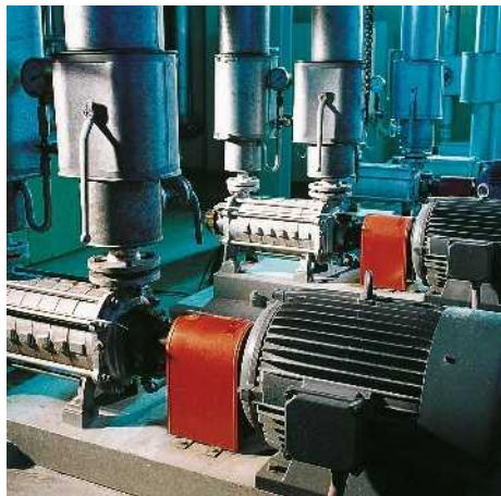
Protección contra marcha en seco, bloqueo y cavitación, umbral de advertencia para aviso de contaminación de filtro.
