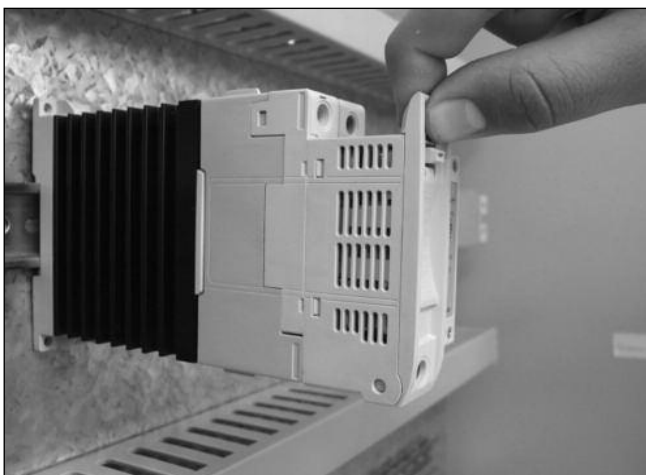
1. Preparación para abrir el portafusibles.
