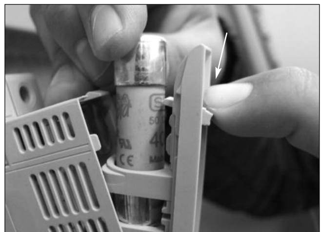
4. Hacer presión hacia abajo en la pestaña del portafusibles para colocar o retirar el fusible
