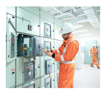
Manilla giratoria MECANISMO de OPERACIÓN ESTÁNDAR PARA la PUERTA del COMPARTIMIENTO AJUSTABLE de PROFUNDIDAD L=500 MM CON CANDADO Y DISPOSITIVO de ENCLAVAMIENTO de PUERTA EN DESMONTABLES C. INTERRUPTOR S7
