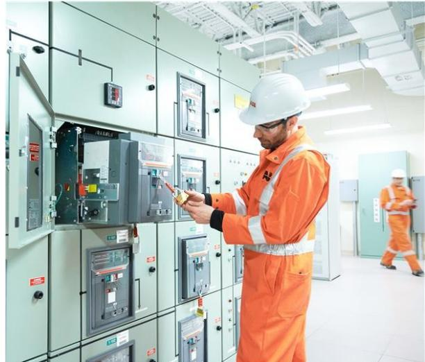
PARTIE FIXE POUR DISJONCTEUR ISOMAX 3 PÔLES DÉBROCHABLE AVEC des
