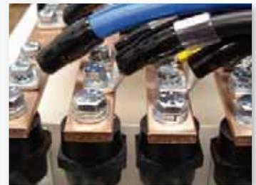
El aislador de "barrica" se emplea como soporte aislante de conductores activos, el cual garantiza una óptima capacidad de aislamiento eléctrico; se puede emplear como soporte de equipos eléctricos ofreciendo elevados valores de resistencia mecánica, y también como elemento espaciador y/o de rigidez de un sistema formado por barras conductoras (en cobre y/o aluminio).
