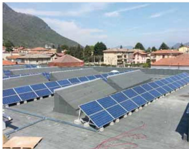
Triángulo doble horizontal a 30° y lastre.
